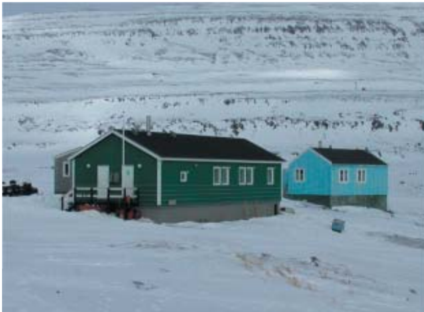
Figur 9.2. Servicehuset i Kangerluk (Diskofjord). Huset rummer bygdekonsultationen, vaskeri og badefaciliteter.
