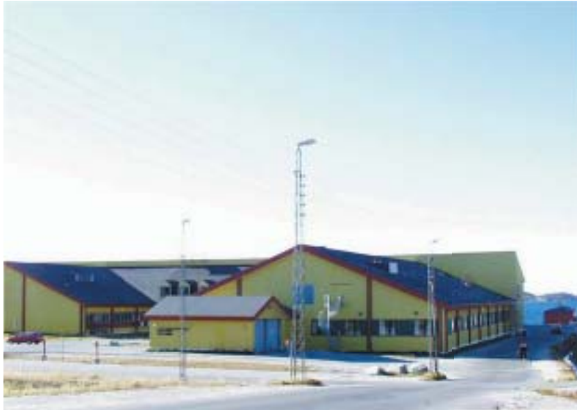
Figur 9.3. Dronning Ingrid's Hospital og Lægeklinikken, Nuuk.
